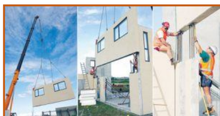
Fig: 14.4 Precast Flat Panel Modules
